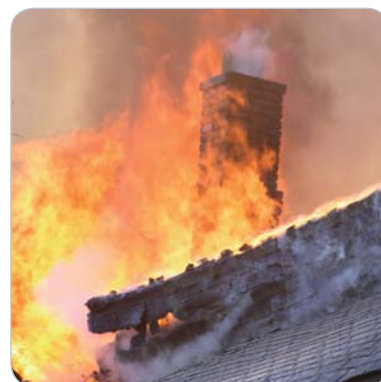
În cazul autoaprinderii funinginei depuse, pe pereții interior ai coșului se dezvoltă temperaturi de 1000^{\circ}\text{C} .
